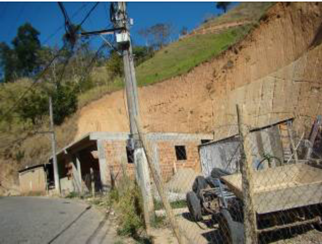
Foto 012 – Corte inadequado do talude
